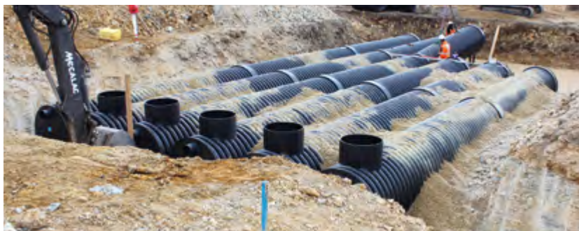
▲ Mise en œuvre du bassin
