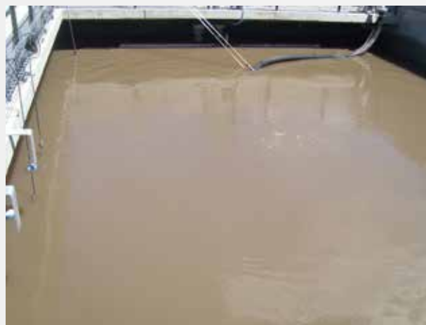
Étape 2 Alimentation et décantation
