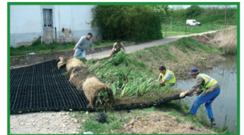
Bâtir les radeaux au bord de l'eau. Dérouler et étirer les géonattes coco pré-végétalisées. Les mettre bord à bord et les attacher entre elles.
