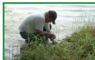
Les clôtures pour les canards se font « à sec » alors que les barrières pour les cormorans se posent une fois l'île à l'eau. Pour la fixation des îles, des sacs de pierres (0.7 à 1 m x 0.25 m) seront jetés et reliés aux angles des radeaux.
