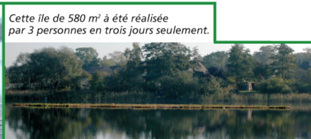
Les clôtures pour les canards se font « à sec » alors que les barrières pour les cormorans se posent une fois l'île à l'eau. Pour la fixation des îles, des sacs de pierres (0.7 à 1 m x 0.25 m) seront jetés et reliés aux angles des radeaux.
