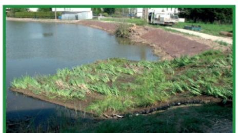
Pousser à l'eau au fur et à mesure de la construction.
