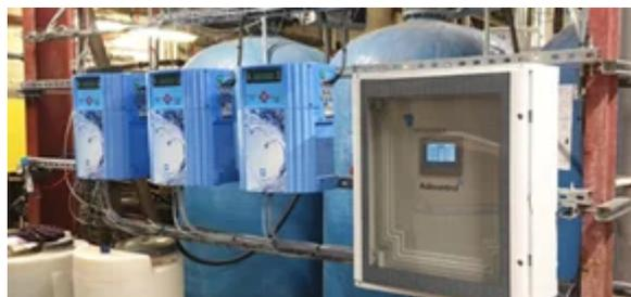
Photo de l'installation complète : Analyseurs en ligne connectés à l'Adicontrol
