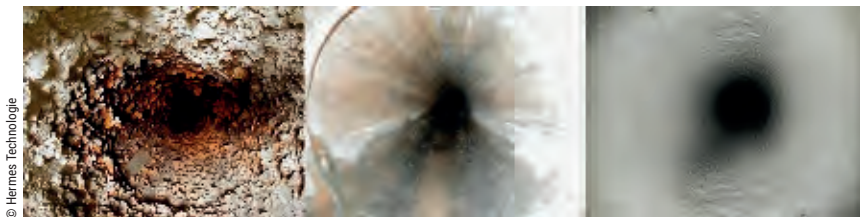
Illustration des différents états d'une conduite d'eau potable: avant intervention, après désincrustation, après projection.
