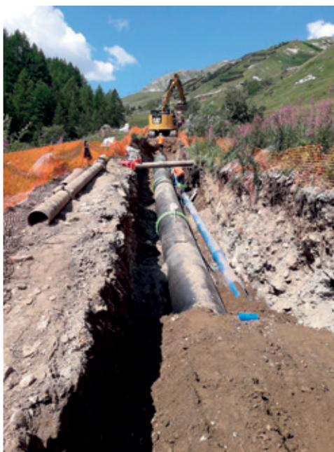
**La tranchée dans laquelle se trouve la conduite forcée héberge également la nouvelle canalisation d'eau potable alimentant Tignes à haute pression depuis le versant opposé.**
