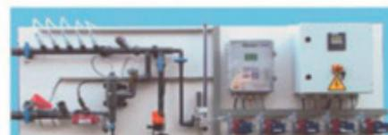
Mesure en continu du pH/Redox, de la vitesse de corrosion et pickling, de la conductivité toroïdale et du chlore résiduel et dosages en ligne
