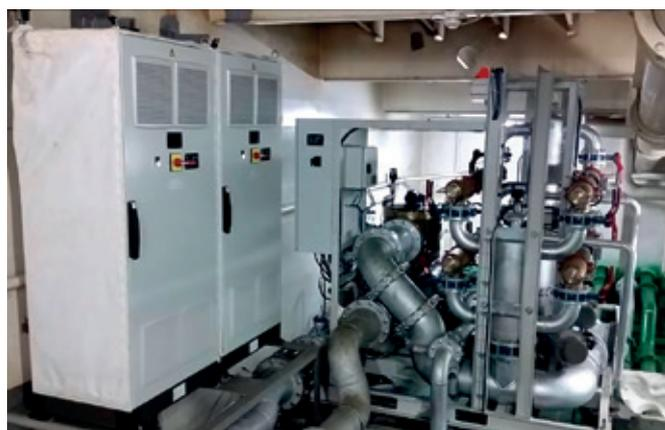
Entièrement automatique, livré sur skid, sur plateforme ou par éléments séparés, BioSea associe filtration et désinfection UV et s'adapte à toutes les configurations de navires existants.
