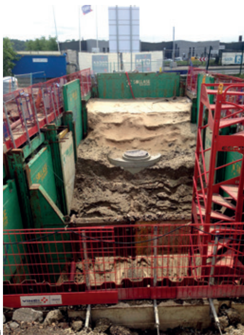
Le chantier présentait plusieurs contraintes environnementales importantes : un réseau de collecte soumis aux régimes des marées, un terrain tourbeux donc extrêmement meuble, une nappe phréatique présente à faible profondeur... etc.
