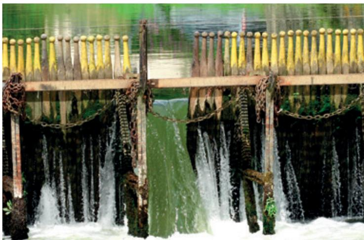
Des centaines d'aiguilles en bois de 3 mètres de hauteur et jusqu'à 30 kg chacune, étaient alignées contre une structure en métal pour former un barrage. En France, plus de 100 barrages à aiguilles sont encore en service.
