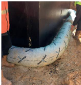
expansé protégées de la pénétration de fines par un géotextile sur 4/5<sup>ème</sup> de la circonférence en partie haute et maintenues par une maille polyéthylène de haute résistance.
