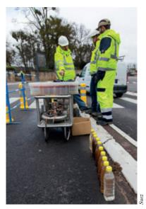
L'Ice Pigging repose sur les propriétés décapantes et tranchantes d'un coulis de glace pompé dans une canalisation. Grâce à la pression, il élimine les dépôts et laisse les parois du tuyau propre et sans obstruction.
