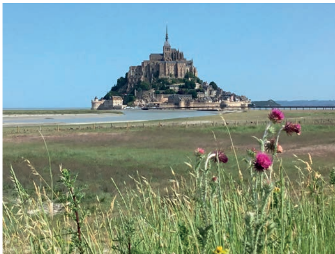
Depuis les années 1930, le Technocentre de Saint-Gobain PAM utilise les terrains particulièrement corrosifs du Mont Saint-Michel pour simuler un vieillissement accéléré des canalisations : au Mont Saint-Michel, 6 mois passés équivalent à 100 ans dans des sols corrosifs normaux !
