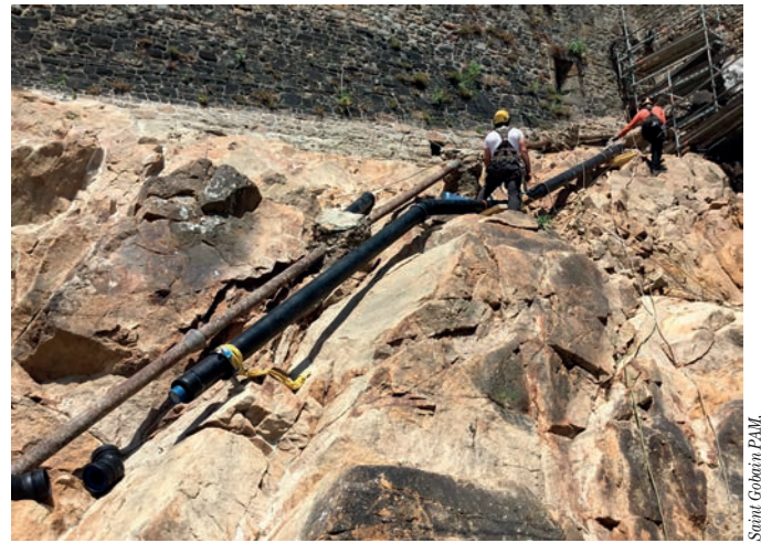
Lors de ce chantier, les équipes de pose ont été confrontées à deux défis de taille : un temps d'action réduit et peu d'indications préalables sur la zone de travail.
