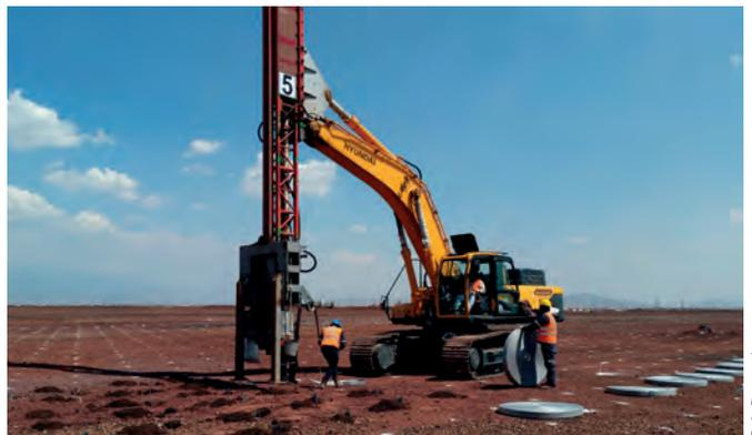
**Installés à des profondeurs allant de 15 à 40 mètres, les drains verticaux RYB Composites, de par leur rigidité et leur résistance à l'écrasement, permettent un important débit de drainage pendant la phase de compression du sol ainsi qu'un délai de pose réduit.**
