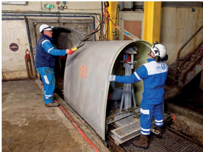
Chaque demi-coque a été acheminée dans l'ancien ouvrage à l'aide de chariots spécialement fabriqués pour le transport et la manutention et tractés par un locotracteur. Elles ont ensuite été posées bout à bout et emboîtées via un joint en élastomère garantissant l'étanchéité de l'ensemble de la conduite.
