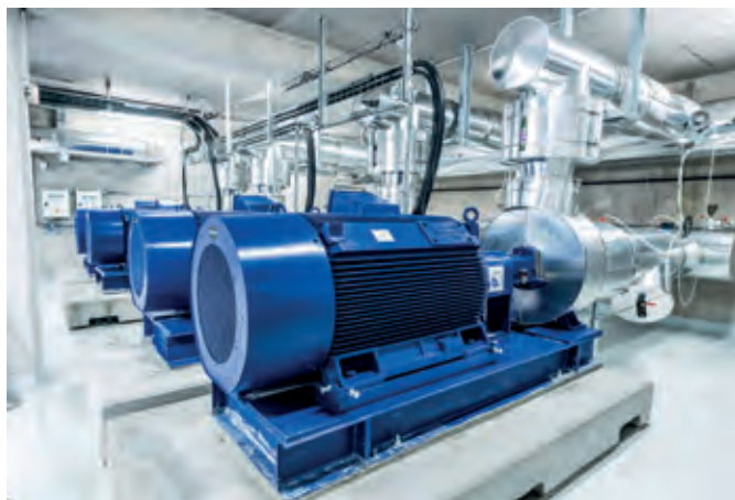
Circuit eau glacée. Pompes KSB Mega CPK 200-500 d'un débit nominal: 760 m 3 /h. HMT nominale: 120 mCE.
