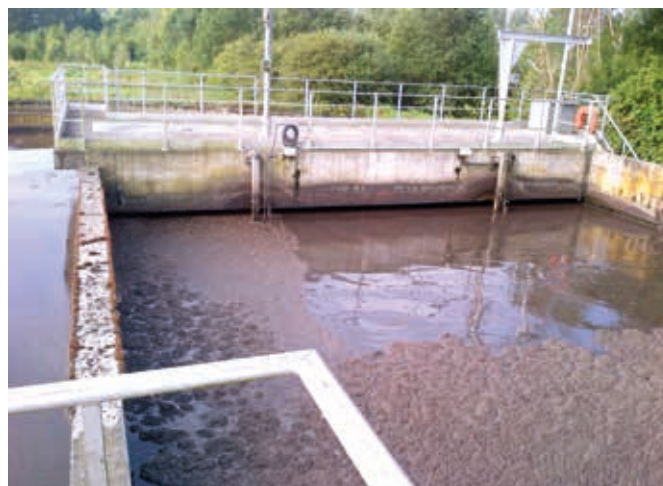
Vue du bassin d'aération de la station d'épuration de Corbie avant remplacement des ponts-brosses.
