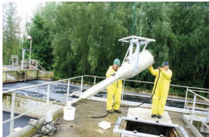
Installation d'un aérateur à vis hélicoïdale Isma-Fuchs, pré équipé de sa chaise.
