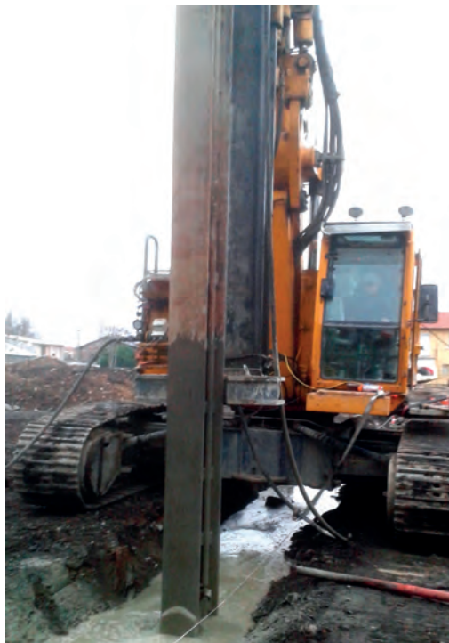
Outil d'injection du coulis bento-ciment permettant la création de la paroi moulée.
