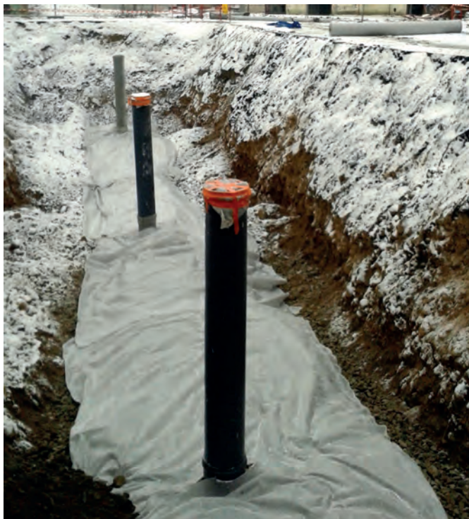
Tranchée drainante de réinjection des eaux traitées.
