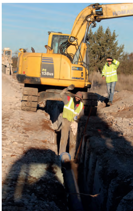
La particularité de ce chantier a été de réaliser, en un seul passage, la préparation, l'ouverture de la tranchée, la pose des tuyaux ainsi que la fermeture de la tranchée.
