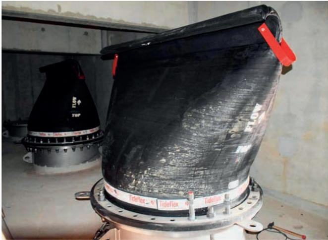
**Vue des clapets Tideflex® installés sur coudes DN1200, chambre 2. Les matériaux qui le composent lui confèrent souplesse et robustesse de manière à résister à la pression et à la dépression qui interviendront suite aux arrêts brusques et fréquents des pompes en évitant leur retournement.**
