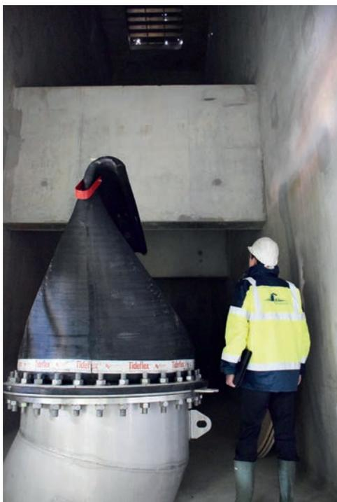
Vue d'un clapet Tideflex® installé sur coudes DN1200, chambre 1. Il se compose d'une partie unique toute en élastomère, renforcée pour cette application d'un renfort interne en acier inoxydable 316 L.
