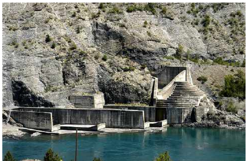
Vue des galeries de fuite en aval du barrage.
