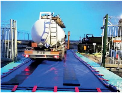
Expert dans le stockage sur rétention de liquides polluants et dangereux, la société DIFOPE conçoit et fabrique des bacs de rétention souples pliages et amovibles pour prévenir et protéger les sols des risques de pollution d'hydrocarbures, huiles et autres produits chimiques. Conformés aux recommandations des DREAL, ils sécurisent le stockage permanent ou occasionnel de petites ou grandes quantités de produits dangereux.
