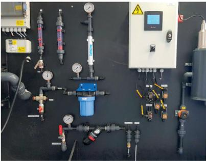
Les usines d'eau potable et stations d'alerte sont aujourd'hui équipées de sondes multi paramètres assurant la mesure en ligne de paramètres tels que l'absorbance UV254 ou le COT. Le suivi de ces paramètres au droit de la ressource permet d'anticiper les changements de qualité d'eau et de piloter efficacement les installations de traitement.
