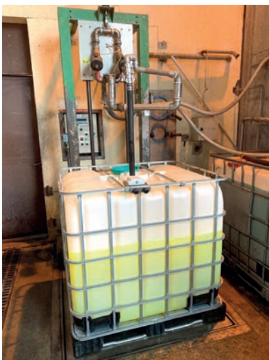
Le Micropilot FWR30 d'Endress+Hauser fournit un accès continu aux informations sur la gestion des stocks.
