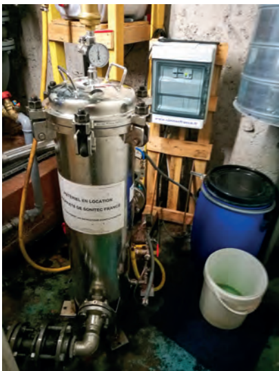
Vue de l'élément filtrant implanté par Sonitec France.
