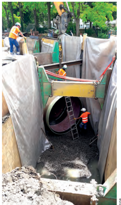
Posée à 4,60 m de profondeur en tranchée ouverte avec une pente de 0,55 %, la conduite fera transiter un débit trentennal égal à 12,3 m 3 /s sous une faible charge (moins de 1 bar).
