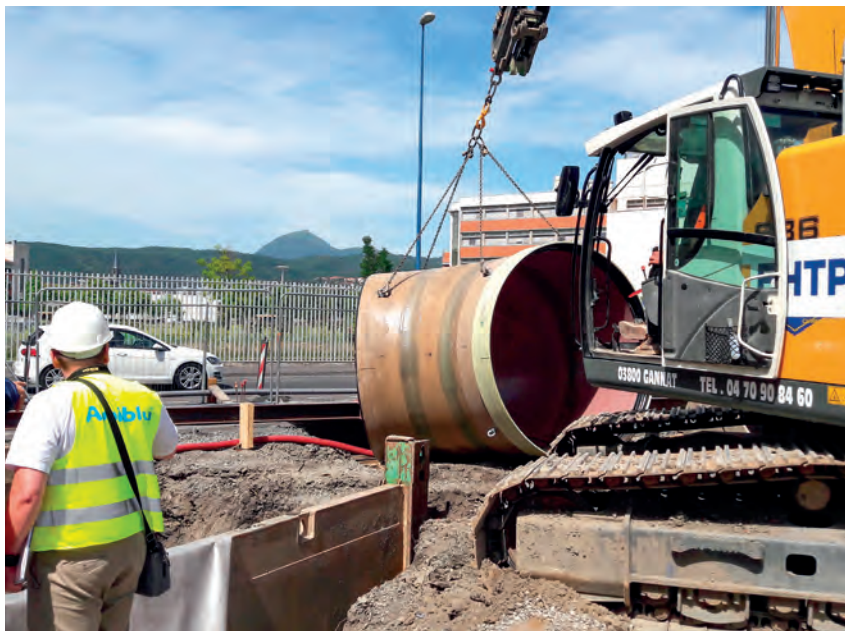
Amiblu a fourni une conduite de 80 ml de diamètre 2.555 mm en PRV centrifugé de la gamme Hobas, de longueur unitaire de 3 m.
