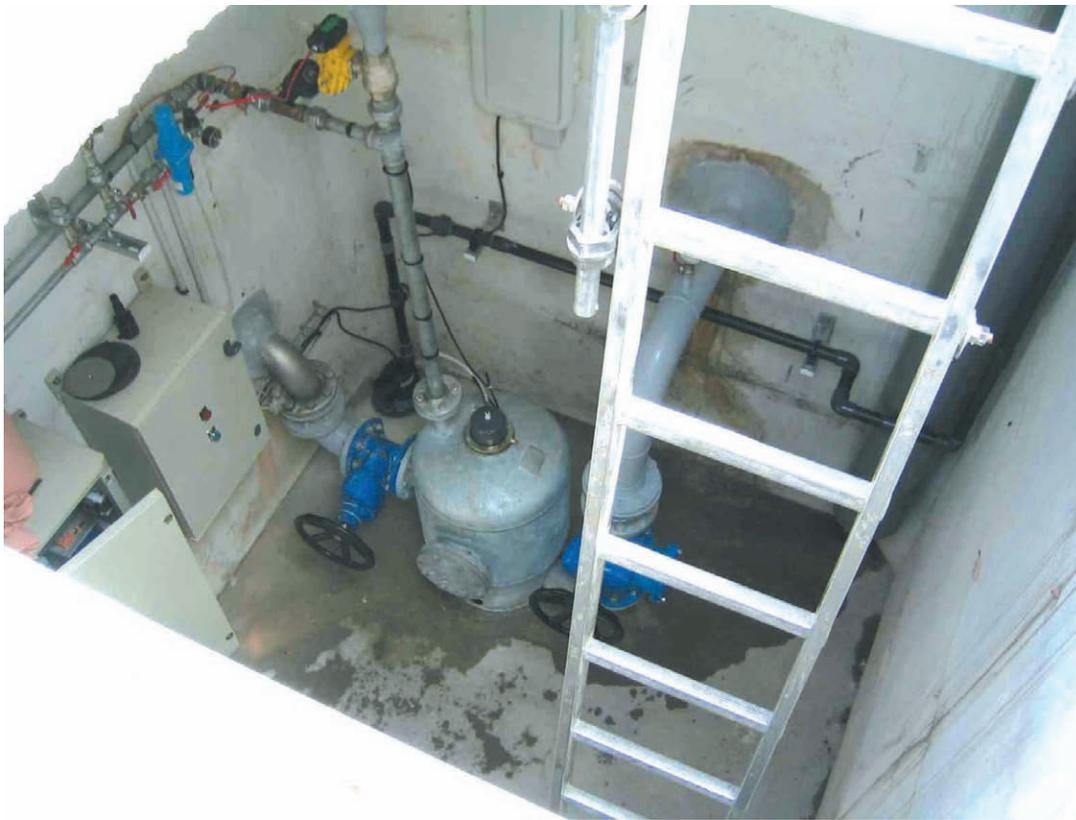
régulier et sans à-coups, le déversement dans le regard au débouché de la conduite de refoulement observé comme régulier, et correspondant au cycle de 40 secondes. Les pressions observées sont de 10 bar en permanence, 6 bar en statique sur le départ du refoulement, 12 bar maximum en début de chasse, sur le départ du refoulement.
