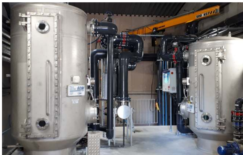
Il s'agit, ici, d'un système de filtre à plateaux de Cifec en conditions réelles d'utilisation dans une piscine publique.
