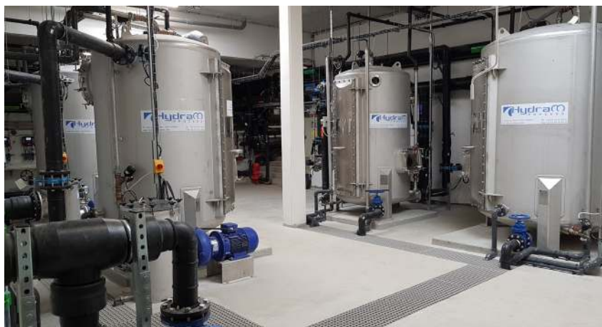
Hydraco Process propose une filtration sur fibres végétales, qui permet de filtrer jusqu'à un micron, comme l'a montré une installation déployée dans un centre aquatique haute-savoie.
