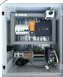
LES AUTOMATES DU PROCÉDE BIOKLEAR (Dosaklear / Muc )
