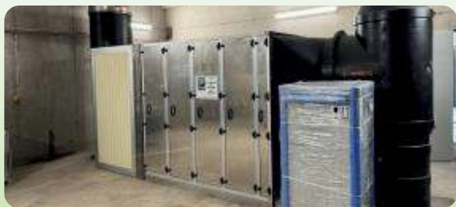
Caissettes charbon actif & alumine
