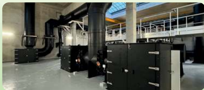
Caissons d'insonorisation pour ventilateurs en PEHD
