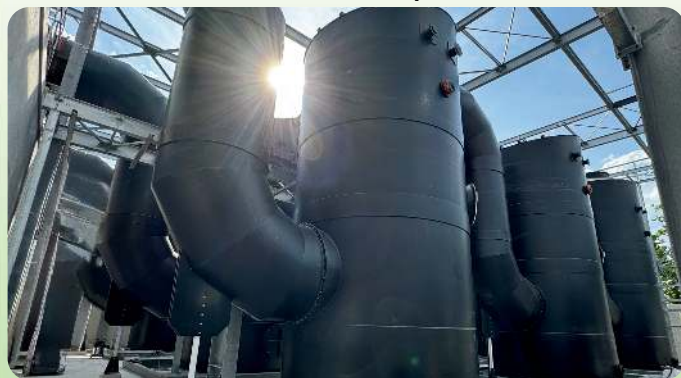
Unité de désodorisation physicochimique: 3 files de 143 000 m³/h unitaire
