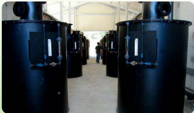
Caissettes charbon actif & alumine
