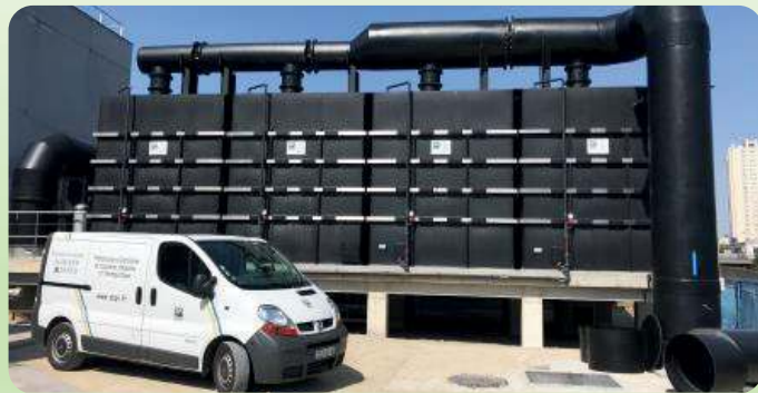
Unité de désodorisation physicochimique: 3 files de 143 000 m³/h unitaire
