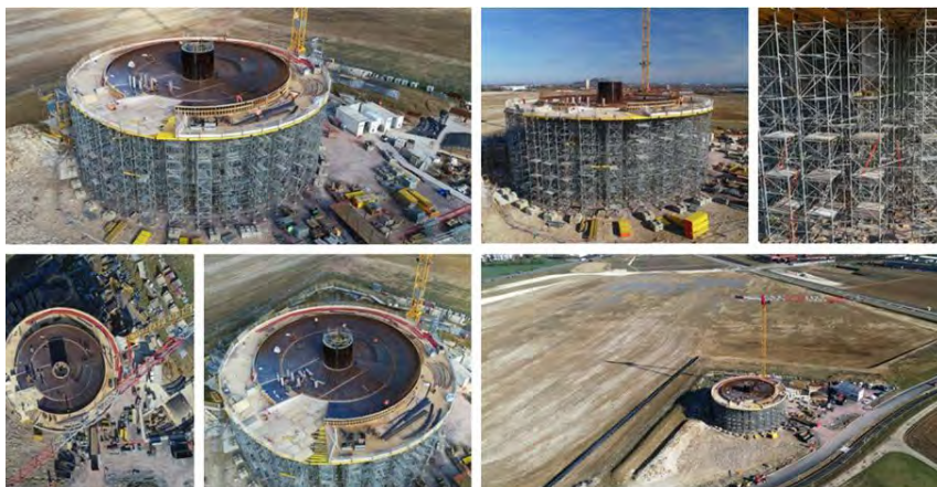
Figure 5: Construction du réservoir de Bully (CALL).
