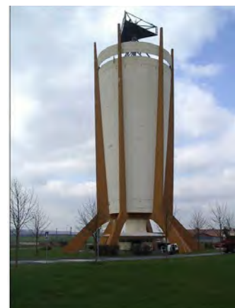
Site : Liévin Type : réservoir sur tour Volume : 3000 m 3
