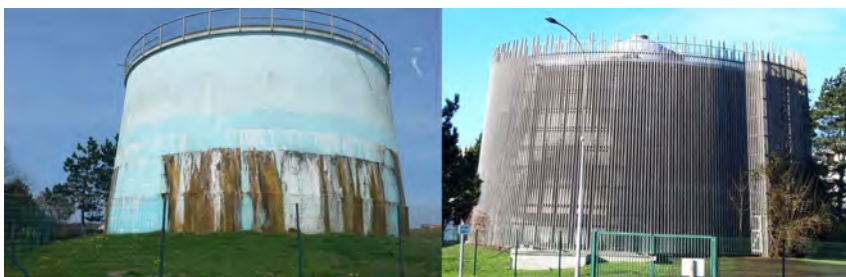
Figures 7: Habillage du réservoir d'Étaples « Rombly » (62) avant/après réfection.
