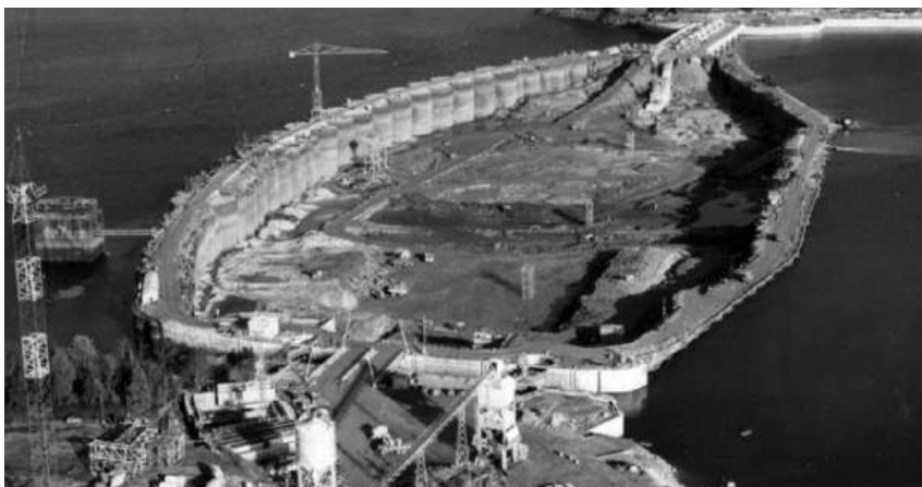
Construction du barrage de la Rance. Vu du chantier asséché durant la construction du barrage.
