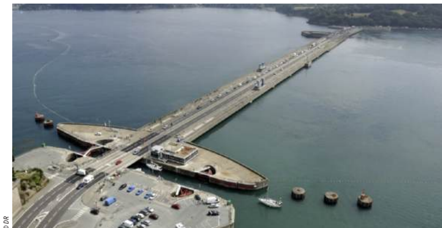
Usine marémotrice de la Rance
