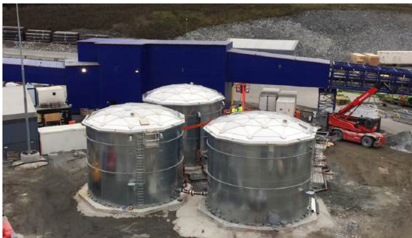
En Norvège, Apro Industrie a réalisé trois réservoirs galvanisés, d'un volume d'eau propre de 1 000 m 3 chacun et couverts par des dômes géodésiques en aluminium dimensionnés pour supporter des surcharges neigeuses sévères.
