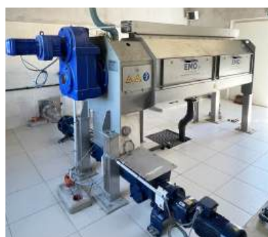
DÉSHYDRATATION DES BOUES presse à vis
