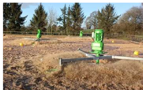
AÉRATION DE SURFACE turbine lente flottante
