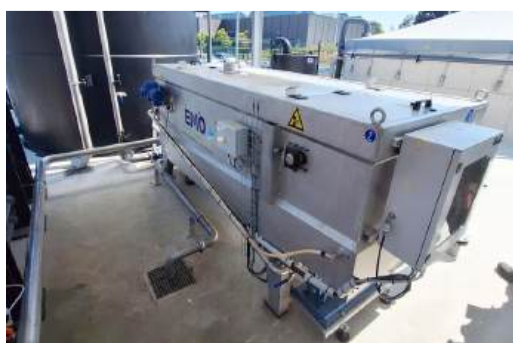
TRAITEMENT DES EFFLUENTS INDUSTRIELS flottateur à air dissous
