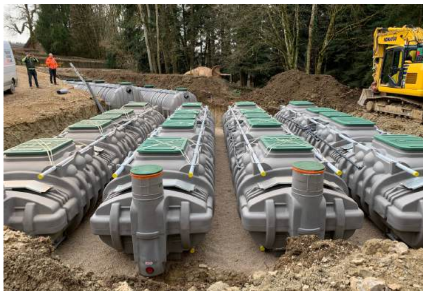
Le filtre à fragment de coco de Premier Tech Eau et Environnement, adaptée à l'assainissement regroupé (ici, un chantier pour un petit collectif) dispose d'une évaluation indépendante du groupe de travail national Epnac.
