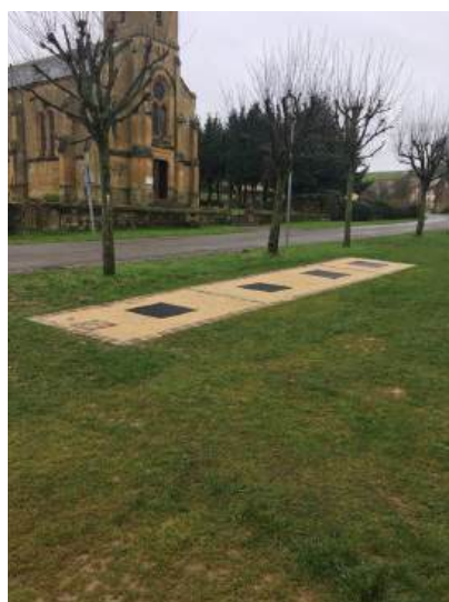
Une fois enterrée, l'installation Fluidifix ne laisse apparaître en surface que les accès nécessaires à l'exploitation et à la maintenance.
