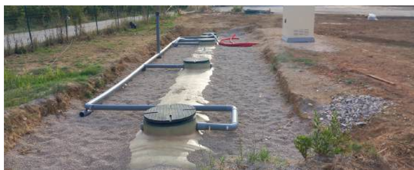
Dans la micro-station Bioxymop Max de Simop, la digestion anaérobie dans le décanteur primaire réduit le volume global des matières, tandis que la recirculation continue des boues depuis le clarificateur vers le bioréacteur garantit la constance du traitement biologique.
