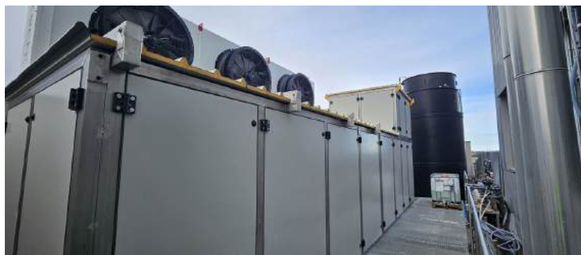
Une seule solution regroupant un évaporateur hybride, un décanteur avec dosage de lait de chaux et un osmoseur de finition de Vivlo permet à un industriel intégrant, dans sa ligne de production, une chaîne de thermolaquage de réduire ses Opex de la gestion des eaux de process.
