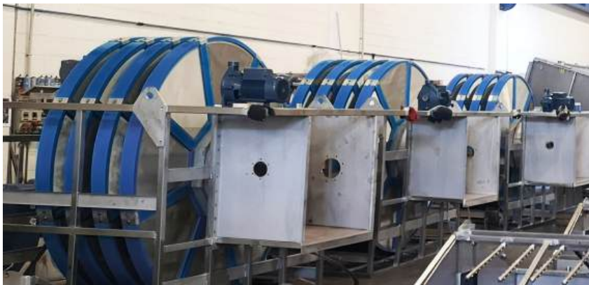
Les filtres à disques HydraDisc d'Andritz apportent un excellent rapport coût/performance pour le traitement tertiaire.
