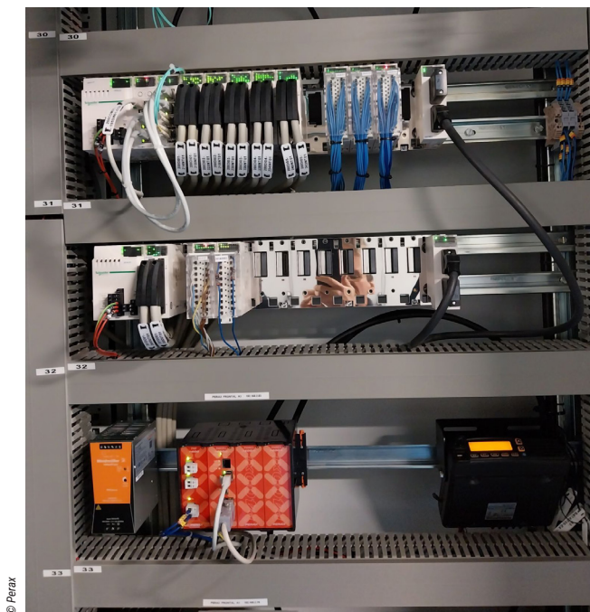
La collecte des données passe le plus fréquemment par un équipement de télégestion (ici, en rouge, un automate connecté P400 IOT de Perax), qui se doit d'être évolutif et interopérable.
