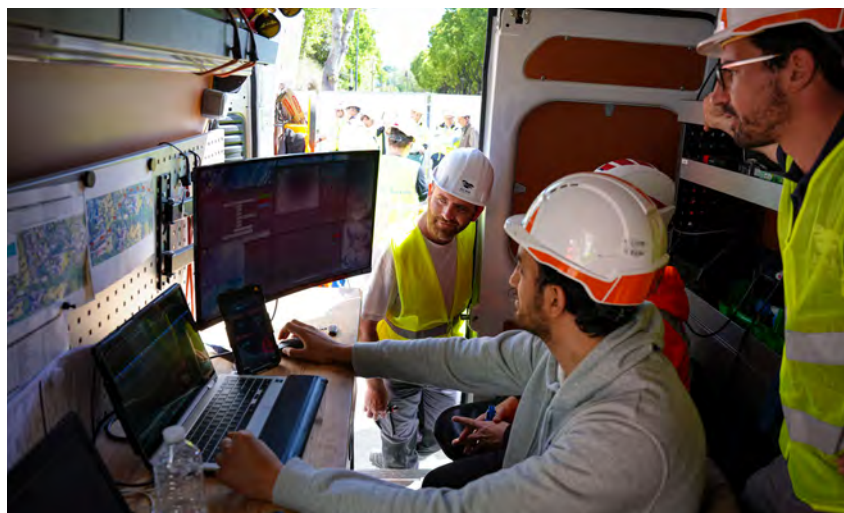
Les équipes d'Acwa Robotics ont accompagné la Régie de l'eau de Bordeaux Métropole dans l'inspection d'une conduite d'eau potable avec un robot Pathfinder.
