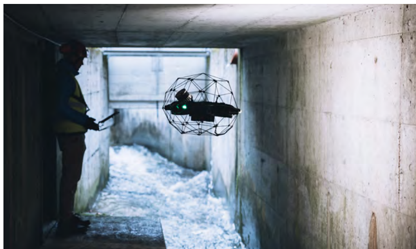
Protégé par sa cage, le drone Elios 3 de Flyability peut évoluer dans des ouvrages difficiles d'accès afin de limiter l'exposition des équipes lors des inspections.
