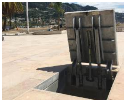
Une trappe en acier, avec assistance par ressort mécanique d'EJ (ici, installée à Menton), réduit l'effort de levage à moins de 25 kg, répondant ainsi aux enjeux de TMS et d'intégration paysagère.
