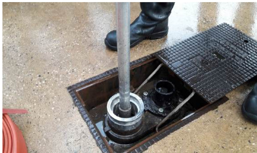
La bouche d'incendie Restreeto de Bayard combine un dispositif Secure de protection du carré de manœuvre et un système de limitation de débit.
