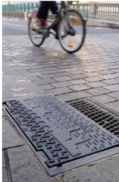
Une grille pour avaloir, à très grande absorption, de type TGA de Fonderies Dechaumont reprend, ici, la skyline de la ville de Toulouse.
