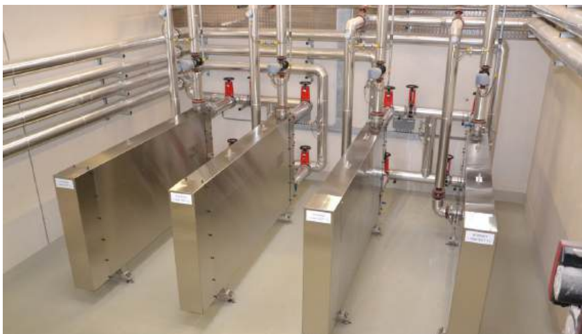
Les échangeur boue/eau et air/eau de Läckeby récupèrent respectivement la chaleur sur les boues digérées ou hygiénisées et des calories sur l'air surpressé alimentant les bassins d'aération des STEP.
