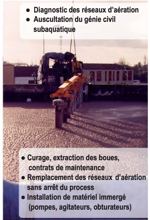
Changement des diffuseurs stations d'épuration de St-Omer
