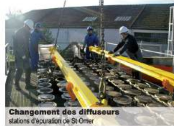
Changement des diffuseurs stations d'épuration de St-Omer
