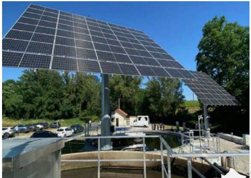
Les trackers solaires TREA 40 000 d'Okwind alimentent, ici, la station d'épuration de Villié-Morgon, avec une emprise au sol minimale.
