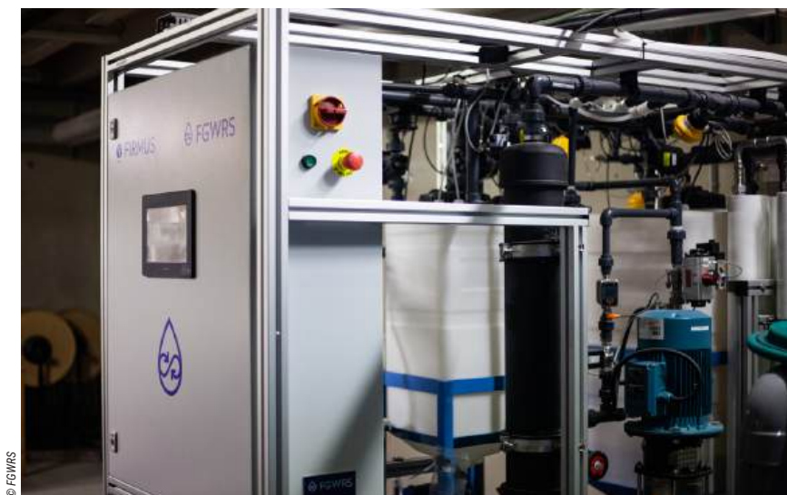
Le skid de déconcentration des chlorures de FGWRs et Gaches Chimie, installé, ici, sur le réseau de traitement d'eau d'une piscine, permet de maîtriser durablement les paramètres de la qualité d'eau, tout en réduisant les volumes de renouvellement.
