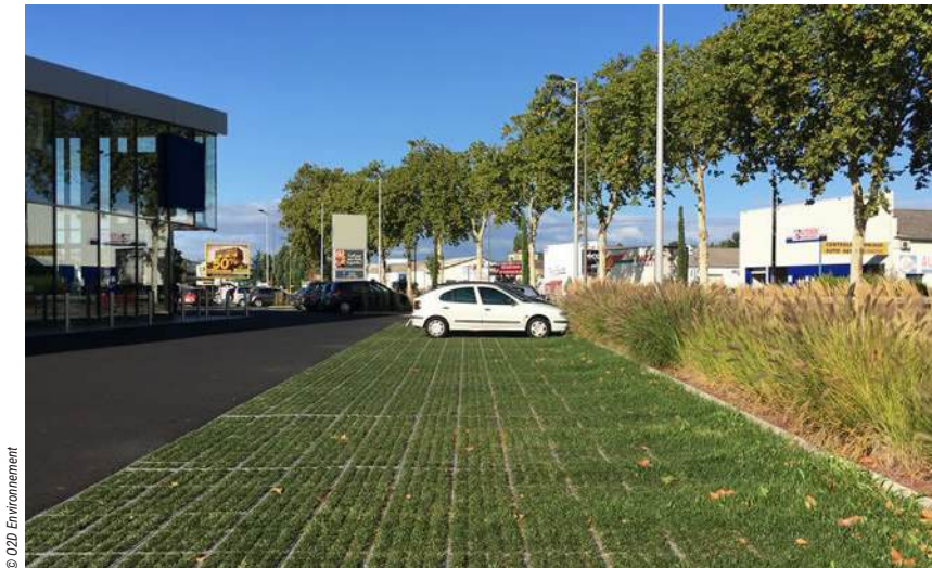
Le système de dalles alvéolées pré-engazonnées O2D Green ou à engazonner sur place TTE MultidrainPlus d'O2D Environnement répond aux exigences techniques d'un stationnement végétalisé.
