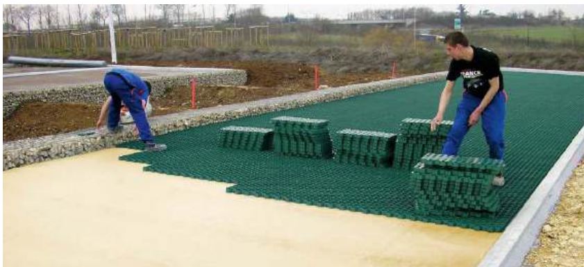
Les dalles Golpla de Funke se caractérisent par une grande rapidité de pose, grâce à leur faible masse et à un système de fixation par crochet/cœillet, tout en étant stables et très résistantes.
