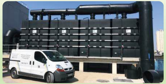
Unité de désodorisation physicochimique: 3 files de 143 000 m 3 /h unitaire
