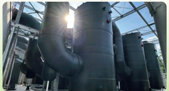
Unité de désodorisation physicochimique: 3 files de 143 000 m 3 /h unitaire
