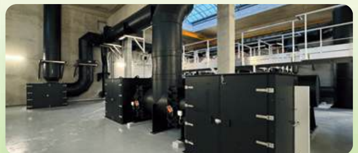
Caissons d'insonorisation pour ventilateurs en PEHD
