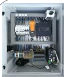
LES AUTOMATES DU PROCÉDE BIOKLEAR (Dosaklear / Muc )
