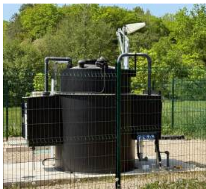
OdoSph'Air propose des installations de pilotage de l'injection de réactifs anti-H 2 S dans les réseaux d'assainissement, selon les paramètres des effluents et du réseau.
