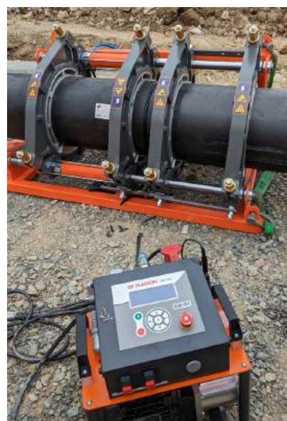
Une soudure bout à bout de canalisations en polyéthylène (PE) est réalisée, ici, avec une machine semi-automatique de Plasson.
