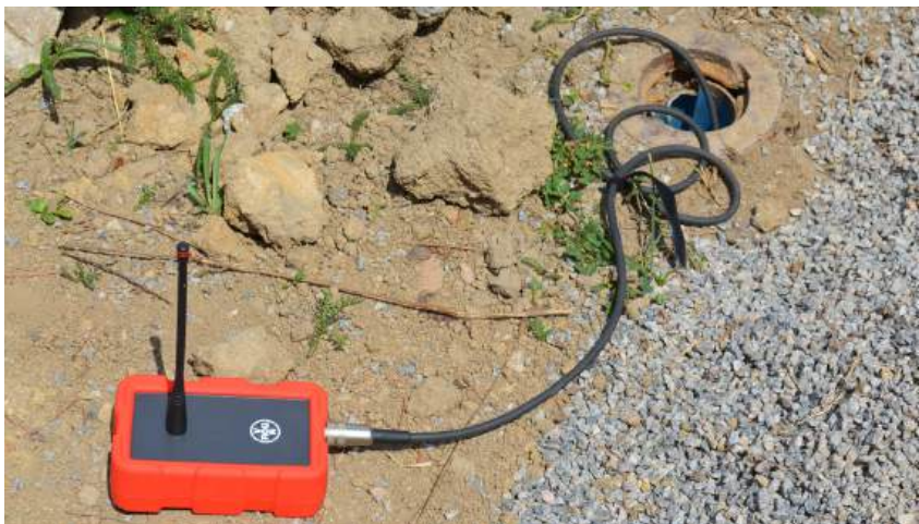
Un corrélateur mobile est mis en œuvre, ici, pour la localisation acoustique précise de fuites sur des conduites d'eau sous pression.
