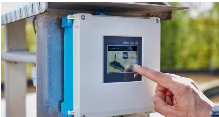
Associé à un capteur radar de niveau FMRx0B, le nouveau transmetteur FlexView FMA90 d'Endress+Hauser récupère l'information de niveau pour la convertir en débit.
