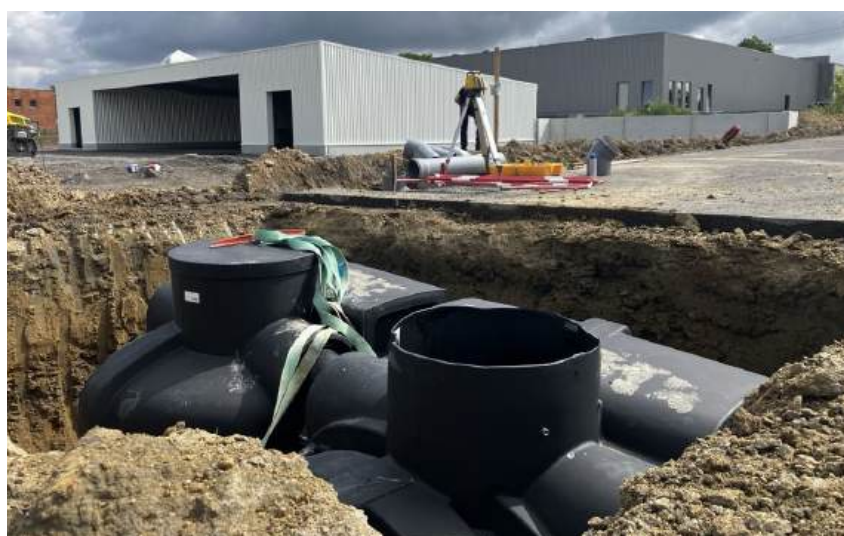
Le séparateur classique (ici, le modèle Oleocido P TN 40 d'ACO) exploite le fait que les hydrocarbures remontent naturellement à la surface par différence de densité pour piéger les phases huileuses.
