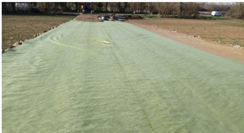
O2D Environnement a mis en œuvre plus de 3 000 m 2 de son géotextile Amter sous une base vie en zone de protection rapprochée de captage d'eau potable, dans le cadre des travaux de la ligne ferroviaire SNCF Poitiers – Limoges.
