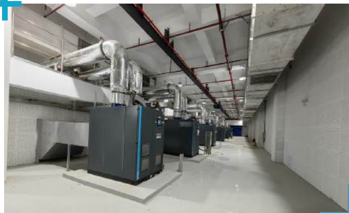
Turbocompresseurs ZB5 VSD+ pilotés par des gestionnaires de centrale Basse Pression Optimizer 4.0 LP
