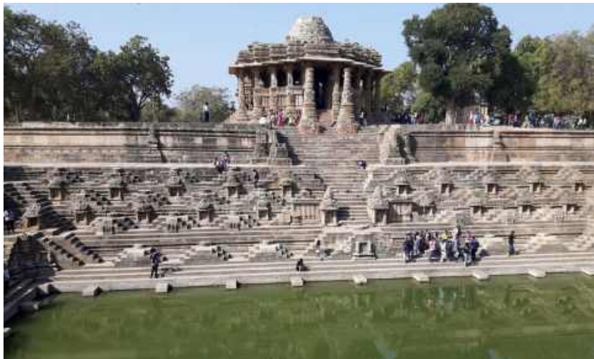
Bassins à gradins Surya Kund du XI e siècle, associés au temple solaire de Modhera (Gujarat) : structure réservoir en pierres appareillées, alimentée par infiltration et précipitations, organisée en terrasses symétriques pour un accès saisonnier à l'eau.
