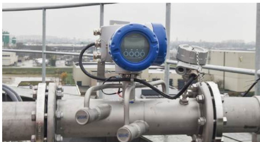
Le débitmètre à ultrasons Optisonic 7300 Biogaz de Krohne mesure le débit et le taux de méthane sur du biogaz, ce qui contribue à réaliser des économies d'installation (aucun système d'analyse supplémentaire).
