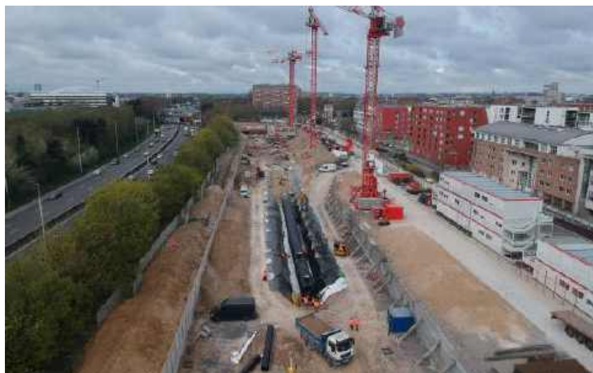
Pour un ouvrage de gestion des eaux pluviales sous la cité administrative de Lille, le choix s'est porté sur une solution en PEHD Weholite (DN2200, volume de 976 m 3 ) de Tubao.
