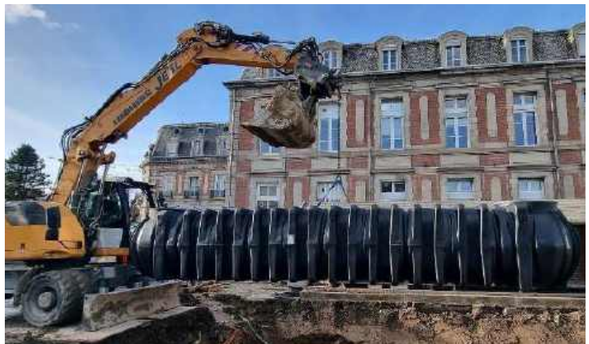
Dans le cadre d'un chantier situé à Colmar pour une gestion durable de l'eau dans la ville, Graf a fourni des cuves Platine XL de 10 000 et 15 000 l.
