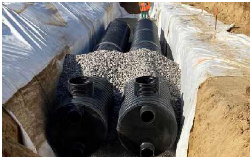
La réalisation sur mesures des bassins Tamp'Eau en PEHD de Polieco permet une insertion le long d'une rue, en limite de parcelle ou encore autour d'un bâtiment, ce qui facilite leur mise en place dans des sites contraints.
