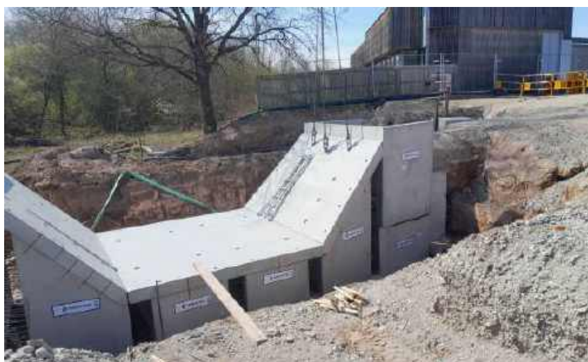
Cimentub a réalisé un ouvrage sur mesure préfabriqué en béton permettant le passage d'un nouveau réseau en cadre au-dessus d'un réseau ovoïde existant, à Héricourt.
