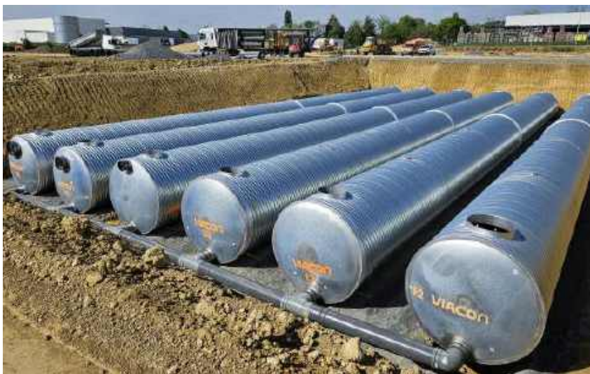
Dans des zones géographiques où le foncier est rare et cher, la gestion des eaux pluviales dans des ouvrages enterrés est la plus pertinente.
