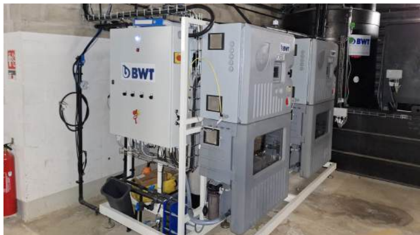
BWT propose, par exemple, le générateur ECO-MX qui fournit, en continu, par électrolyse de sel, une solution chlorée désinfectante et fraîche.
