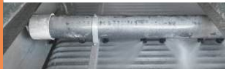
SURFACE D'ÉCHANGE EMBOUÉE
