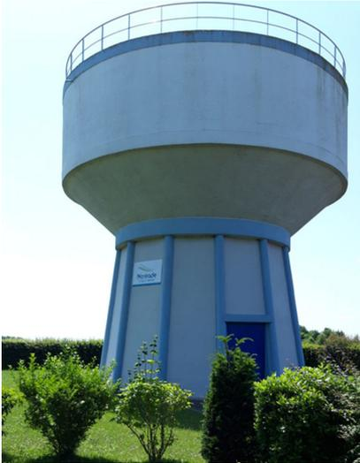
Figure 2a. Réservoir de Marquion de 200 m<sup>3</sup> / Noreade (59).
