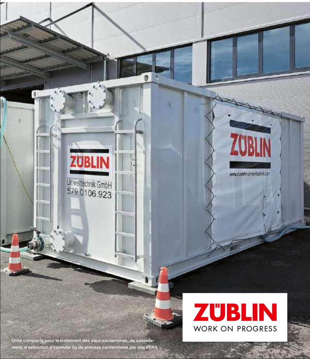
Unité compacte pour le traitement des eaux souterraines, de ruissellement, d'extinction d'incendie ou de process contaminées par des PFAS
