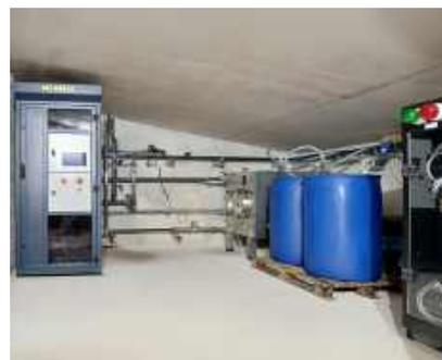
En 2025, Nereus a installé, dans un immeuble du promoteur immobilier Bouygues, une solution AquaFiber dont le rôle est le traitement, le filtrage et la désinfection des eaux grises pour produire jusqu'à 80 % d'eau de qualité A+. L'installation de recyclage se compose de multiples étapes permettant d'éliminer les agents pathogènes, les polluants organiques et les microparticules et d'obtenir une eau conforme à l'arrêté du 12 juillet 2024 relatif aux conditions sanitaires
