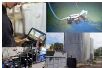
CTP environnement a développé une nouvelle solution d'entretien des réservoirs maintenus en eau avec son partenaire Horizon Data Services, en regroupant plusieurs opérations en une seule intervention. Il s'agit du pompage des boues accumulées au fond du réservoir à l'aide d'un drone amphibie « pompeur » avec assistance vidéo, de l'inspection de l'intérieur de la cuve en simultané avec un drone sous-marin « éclairateur », de la
